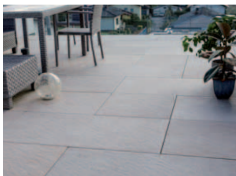
Terrassenverlegung im Außenbereich
